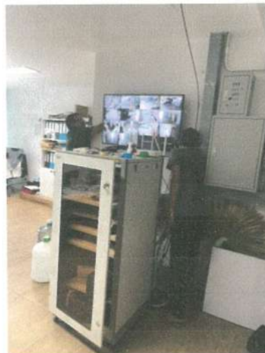
รูปภาพที่ 2.52 การตรวจสอบการทำงานของระบบ CCTV
